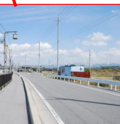
橋せまく、歩道なし。交通量もあるため、危険。橋を渡った道路は広く、歩道が左にあるため、橋手前で左に横断
