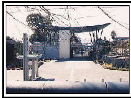
大津市 (坂本駅前整備)
