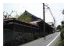
79 元本陣 道を挟んで庭園が残る
