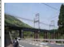
88 三重県境 近鉄の鉄橋をくぐると県境はもうすぐ
