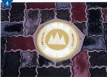
▲誘導埋め込みサイン設置(完了)
